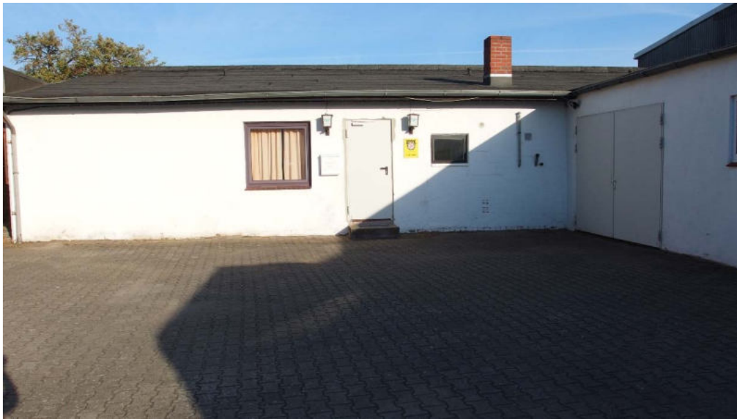
Abb. 9: Blick nach Westen auf die Räume des Oldtimer-Clubs im Hofgebäude.
