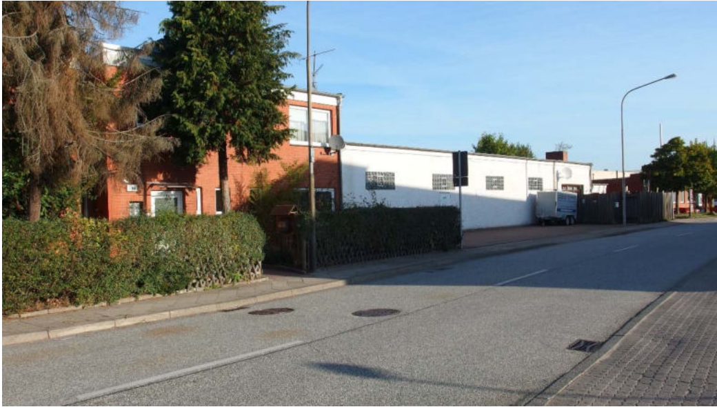
Abb. 3: Blick nach Nordosten entlang der Welsbachstraße. Im linken Bildrand befindet sich im EG das Büro des Lesezirkels, im Obergeschoss befinden sich Wohnungen. Im Hintergrund ist die Lagerhalle des Lesezirkels zu erkennen.
