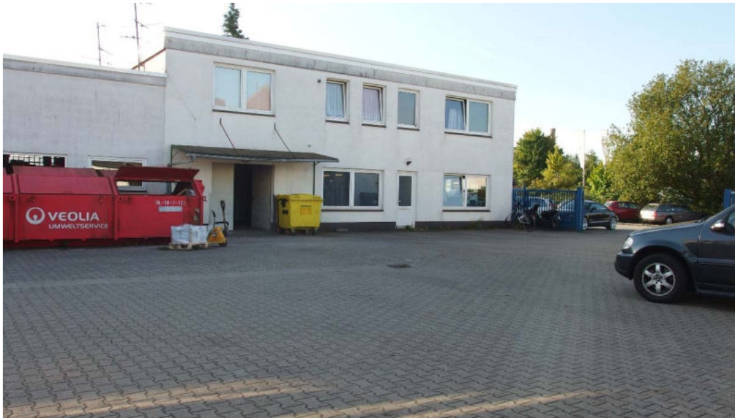
Abb. 5: Blick nach Südosten vom Hof auf das Bürogebäude und den Eingang zum Lager des Lesezirkels.
