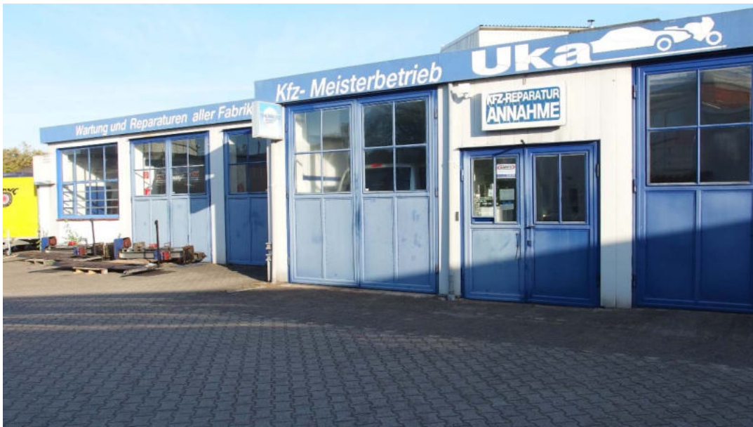
Abb. 6: Blick nach Nordwesten vom Hof auf die Kfz-Werkstatt Uka.
